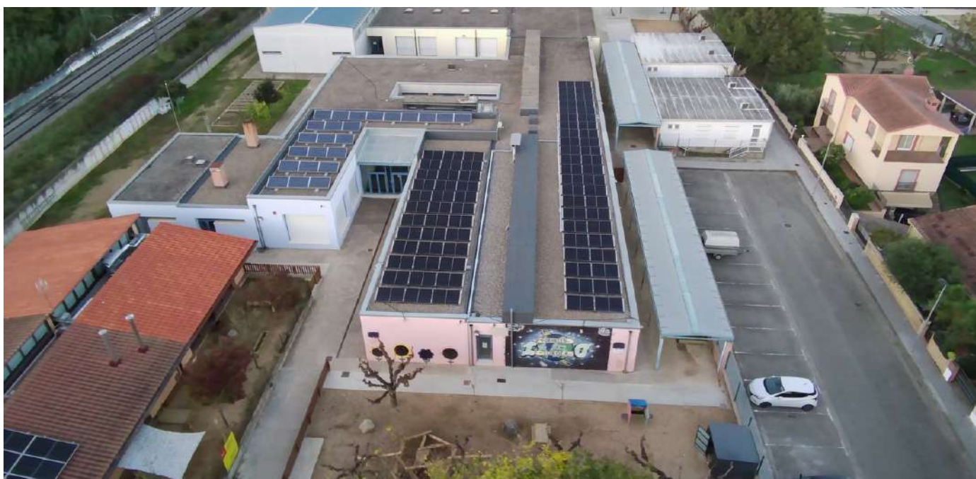
Instal·lació de les comunitats energètiques a Fornells de la Selva
