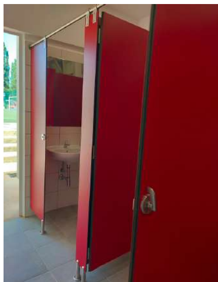
Remodelació dels lavabos del camp futbol de Pont Major de Girona
