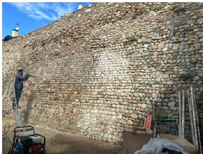
Estabilització de la muralla de Cervia de Ter
