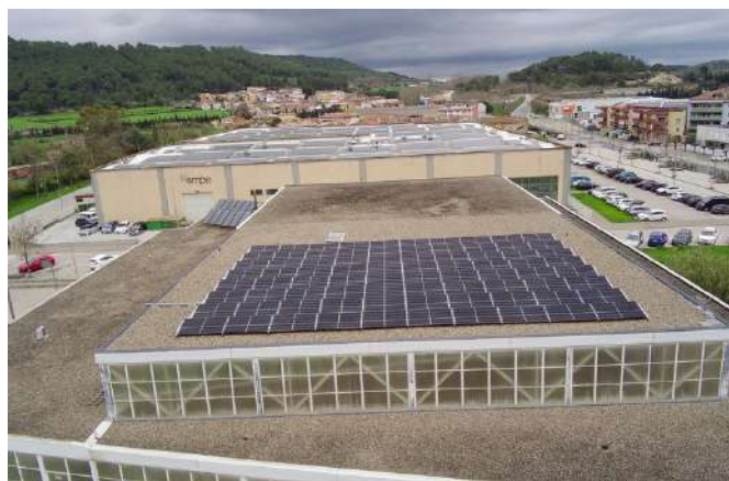
Instal·lació de les comunitats energètiques a Sant Julià de Ramis
